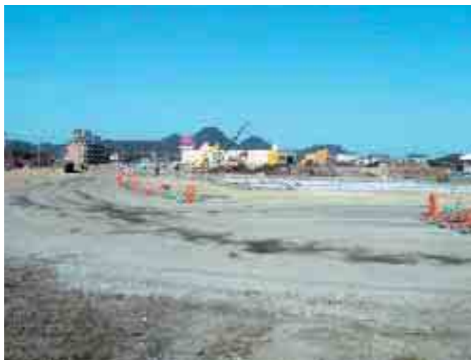
▲建設中のイオンタウン始良
