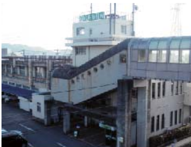
▲老朽化が進んでいる本館庁舎
