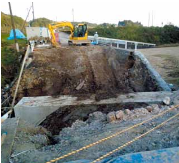
▲豪雨災害の復旧工事が進む県道
