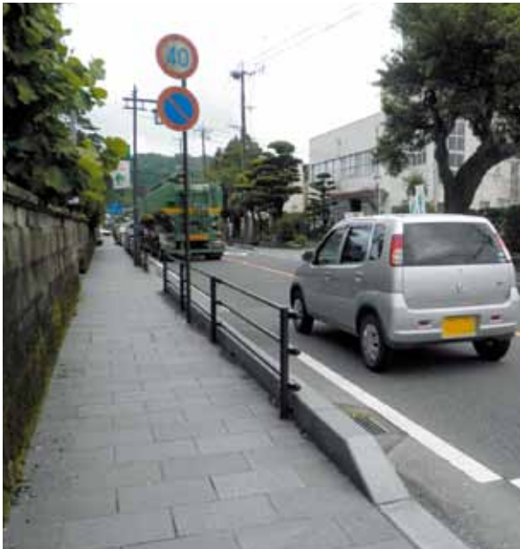
▲ガードパイプを見えやすく
