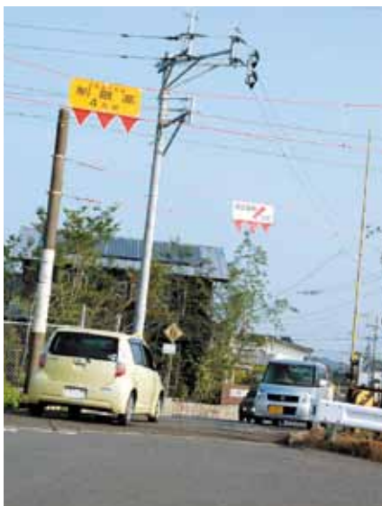
▲狭くて危険な地蔵橋踏切
