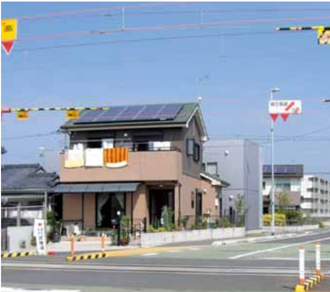
▲太陽光発電パネルの設置補助を早く
