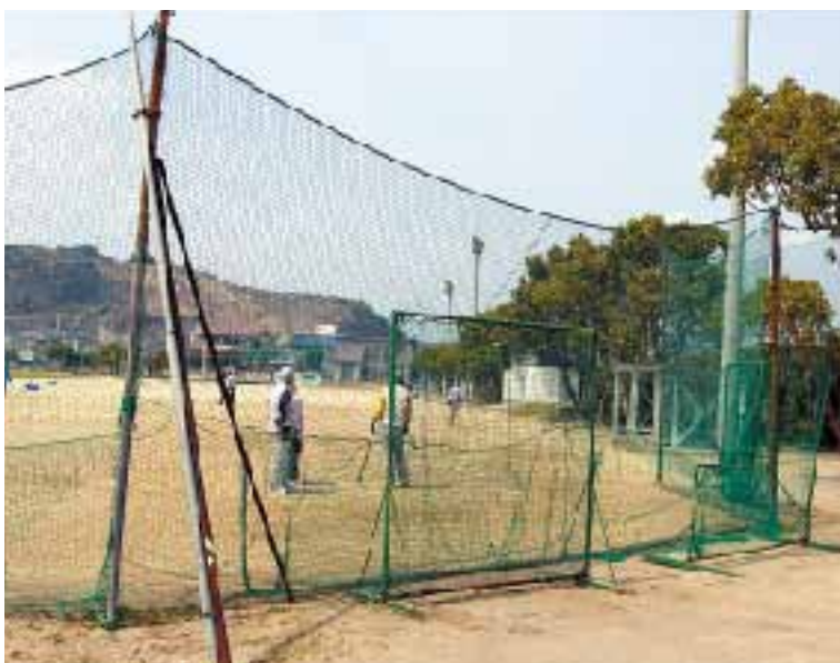
▲バックネットの建て替えを望む（加治木運動場）
