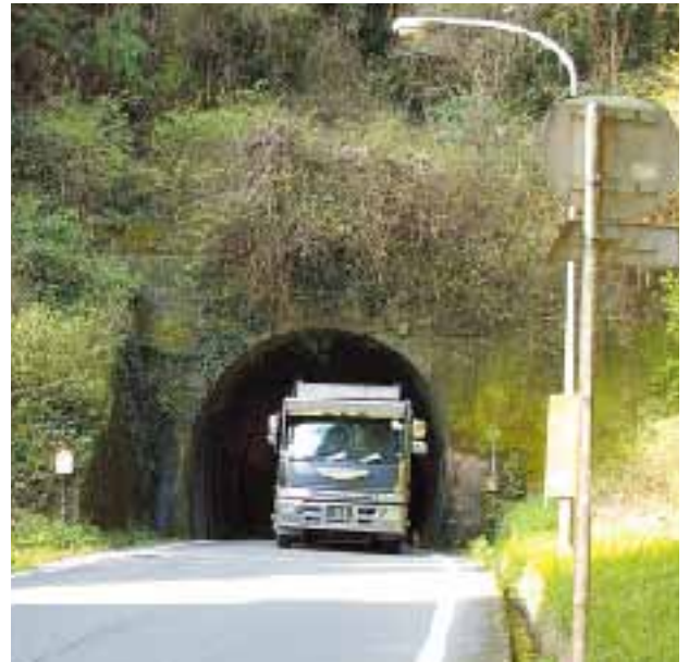
▲早期の2車線化が必要な宇都トンネル
