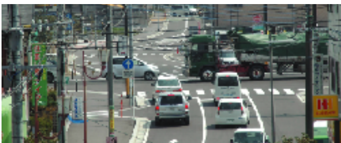
▲ 完成した街路宮島線
