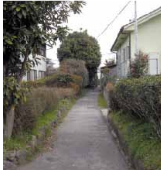
▲道路整備が望まれる堅野地区
