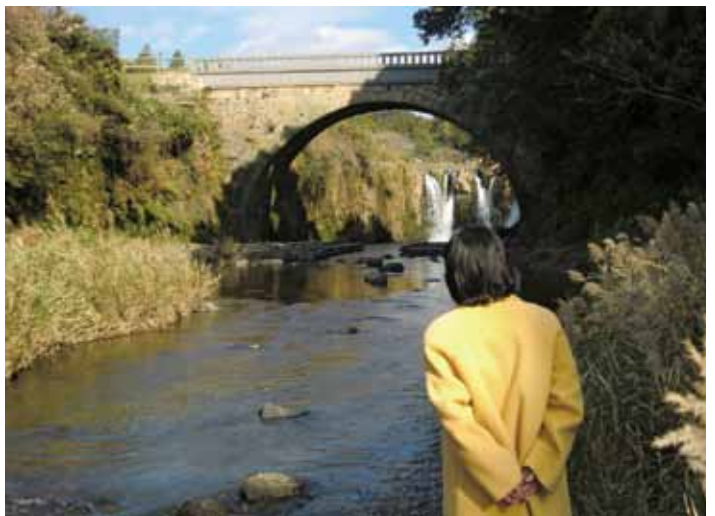
▲整備された金山橋
