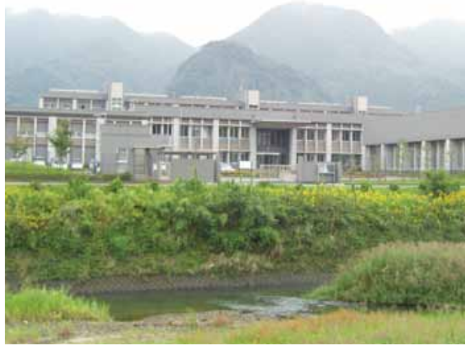
▲PFI方式で建設された県警察学校（平松地区）
