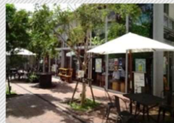
宮崎県日南市・油津商店街 商店街の既存スーパーの一部を解体し、中庭に面する建物1階部分をガラス張りの店舗にリノベーション
