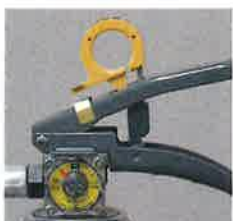
× 安全栓の抜けかけ
