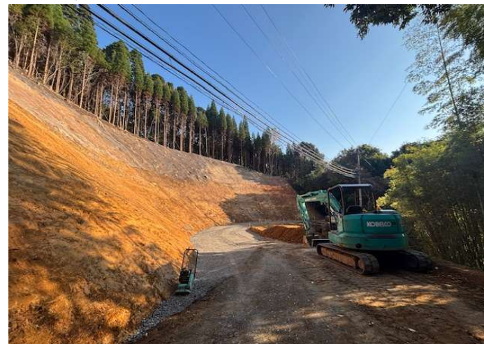
施工状況(令和7年12月3日現在)
