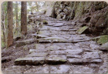
石畳敷設状況
