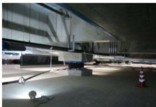
図 7-5 免震層と免震装置の例
