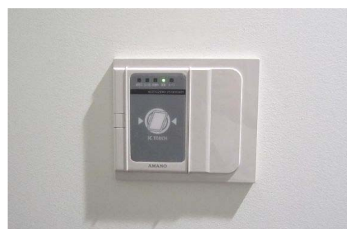
図 7-29 I C カードや手のひら認証による入退室管理の例
