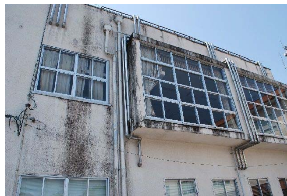
図 2-20 外壁に露出した配管（蒲生庁舎）
