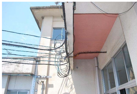
図 2-18 外壁に露出した配管（始良庁舎）
