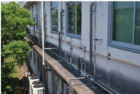
図 2-19 外壁に露出した配管（加治木庁舎）
