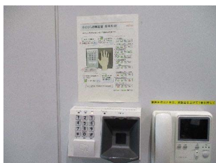
図 7-29 I C カードや手のひら認証による入退室管理の例
