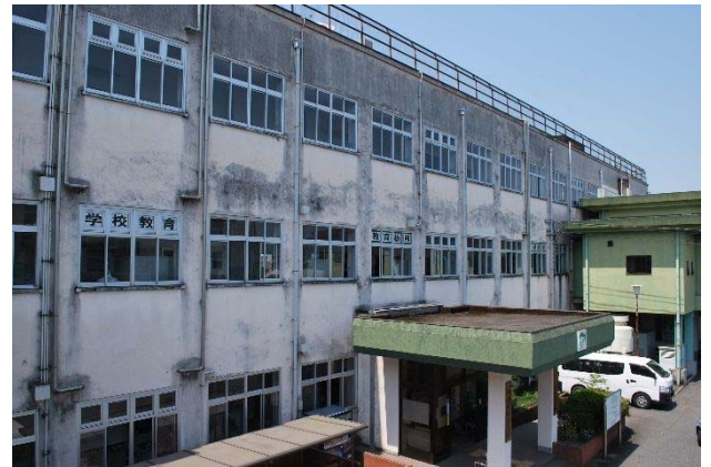
図 2-4 加治木庁舎南庁舎（昭和 35 年度築）
