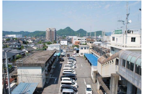
図 2-32 別棟配置の始良庁舎 (始良庁舎)
