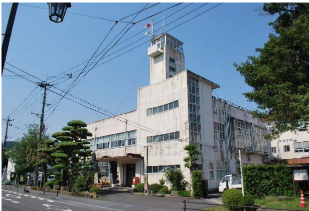
図 2-3 蒲生庁舎本館（昭和 29 年度築）
