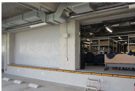
図 7-4 生活支援物資等の備蓄倉庫の例
