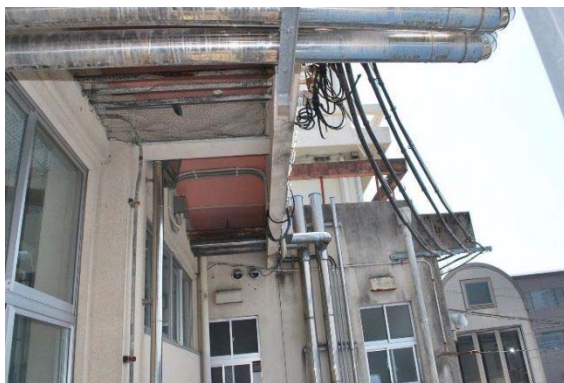
図 2-17 外壁に露出した配管（始良庁舎）
