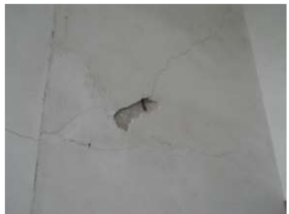
図 2-6 壁のひび割れと鉄筋の露出 (加治木庁舎)
