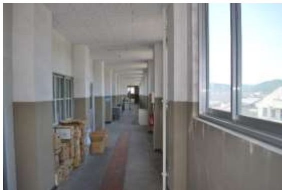
図 2-37 空きスペースがある3階フロア (加治木庁舎)
