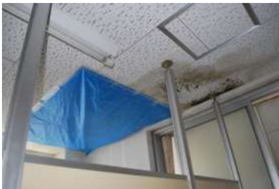
図 2-13 天井漏水跡(加治木庁舎)
