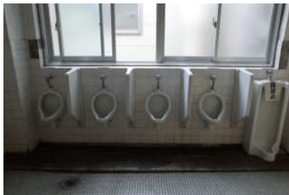
図 2-27 旧型の衛生器具（加治木庁舎）
