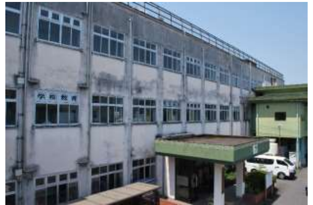
図 2-4 加治木庁舎南庁舎（昭和 35 年度築）
