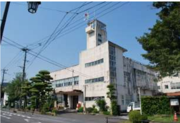
図 2-3 蒲生庁舎本館（昭和 29 年度築）
