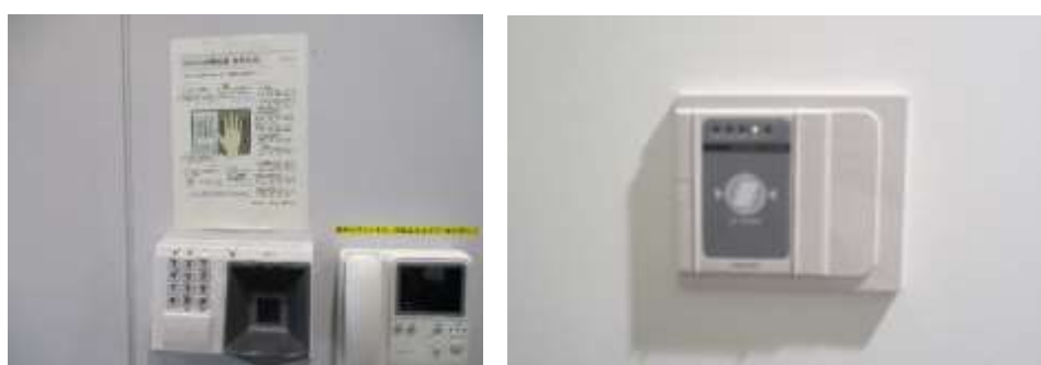
図 7-29 ICカードや手のひら認証による入退室管理の例
