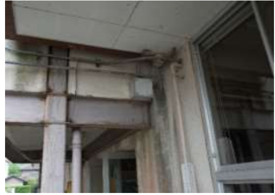
図 2-8 必要間隔(クリアランス)の不足 (蒲生庁舎)
