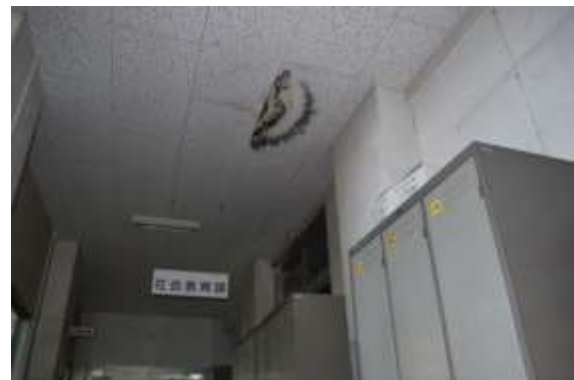
図 2-14 天井漏水跡(加治木庁舎)
