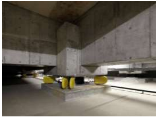
図 2-40 免震装置のイメージ
