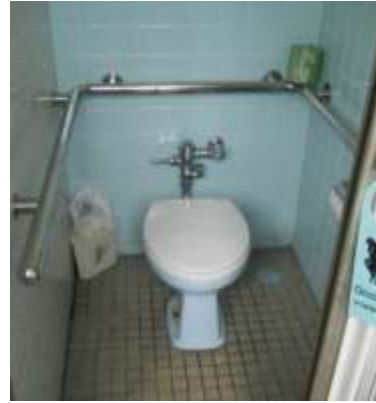
図 2-26 旧型の衛生器具（蒲生庁舎）
