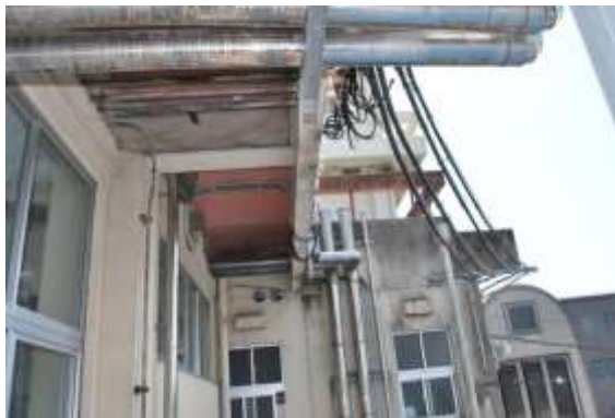
図 2-17 外壁に露出した配管（始良庁舎）
