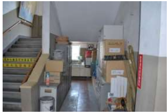
図 2-34 階段に置かれた書棚等 (加治木庁舎)
