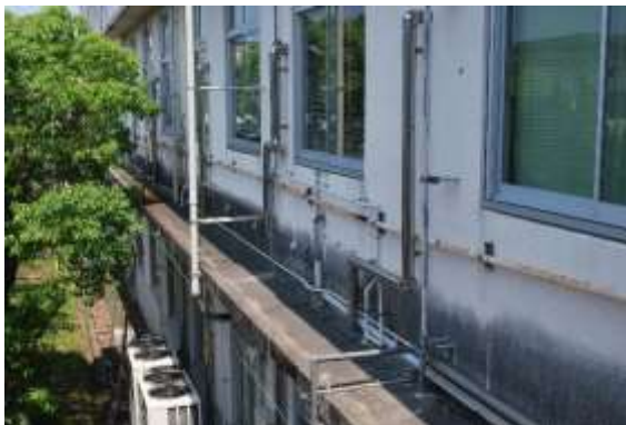
図 2-19 外壁に露出した配管（加治木庁舎）
