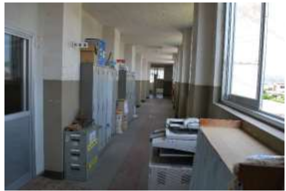
図 2-30 廊下に置かれたコピー機 (加治木庁舎)
