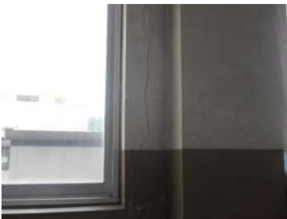
図 2-5 壁のひび割れ(加治木庁舎)
