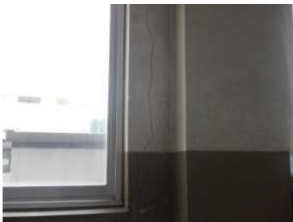
図 2-5 壁のひび割れ(加治木庁舎)
