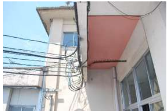
図 2-18 外壁に露出した配管（始良庁舎）
