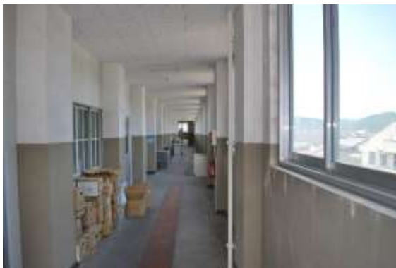
図 2-37 使用されていない部屋が並ぶ3階 (加治木庁舎)
