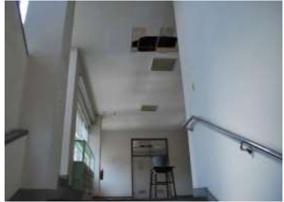
図 2-16 天井漏水跡（蒲生庁舎）
