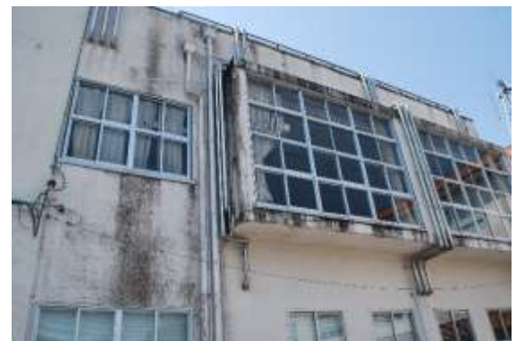
図 2-20 外壁に露出した配管（蒲生庁舎）
