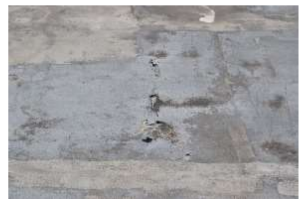
図 2-12 屋上防水の劣化 (加治木庁舎)
