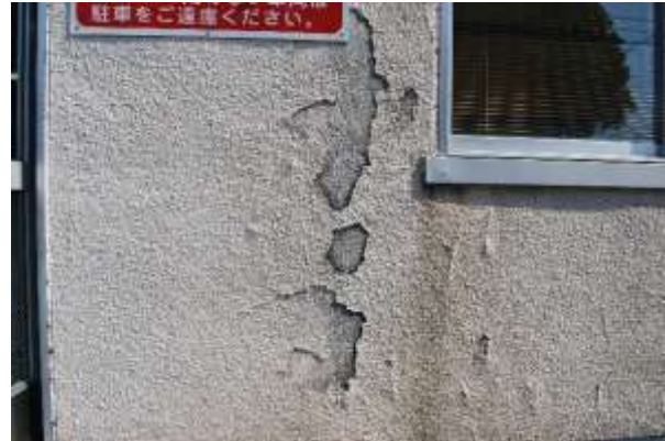
図 2-10 外装仕上げの剥離 (蒲生庁舎)
