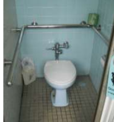
図 2-26 旧型の衛生器具（蒲生庁舎）
