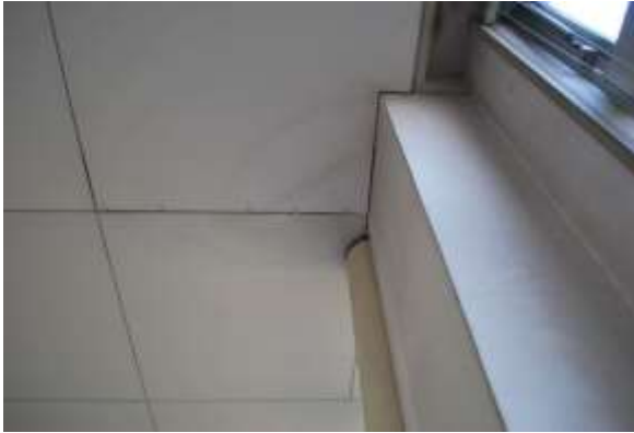
図 2-15 天井漏水跡（始良庁舎）
