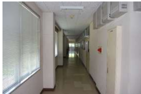
図 2-38 使用されていない部屋が並ぶ3階 (蒲生庁舎)
