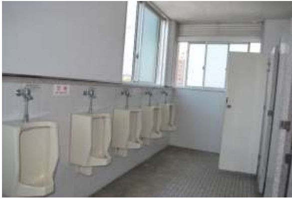
図 2-25 旧型の衛生器具（始良庁舎）
