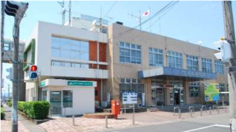
図 2-2 始良庁舎本館（昭和 35 年度築）
