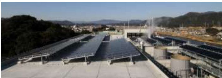
図 2-48 太陽光発電装置を設けた庁舎のイメージ
