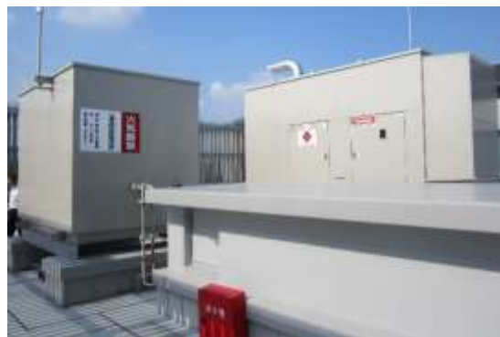
図 7-3 非常用発電設備の例
