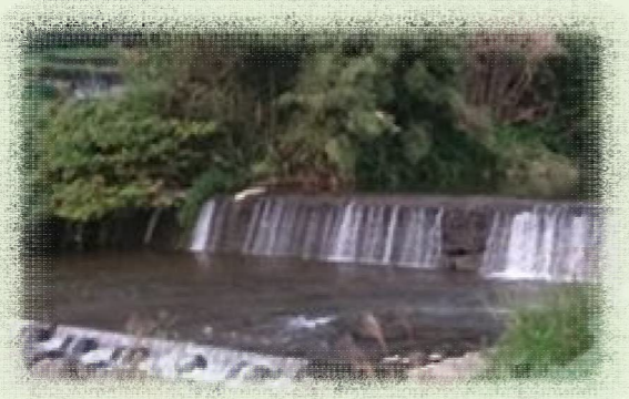
整備された用水路
