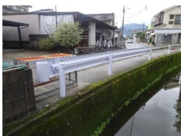
【駐車場入口にガードレール設置】
