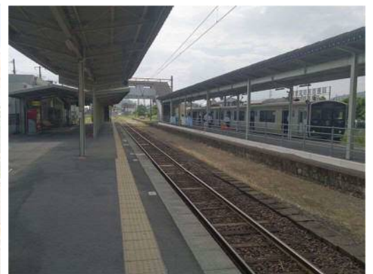
◆ 加治木駅の 1 番と 3 番ホームを結ぶ跨線橋
