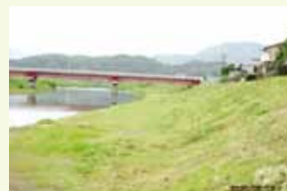
草払い作業後の状況
