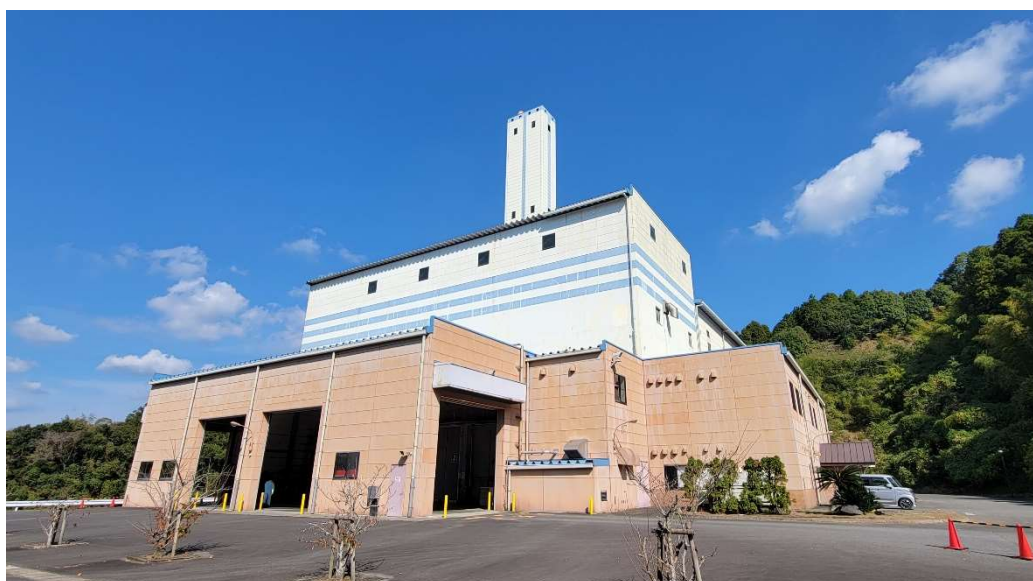
図2-1-1 あいら清掃センター 施設外観
