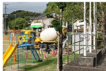
遊具移設・体育倉庫新設
