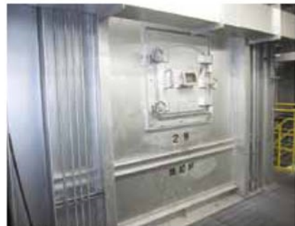
●焼却炉 およそ900℃の高温でごみを燃やします。有害物質・においも分解されます。
