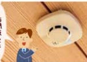
住宅用火災警報器は消防法で設置が義務付けられています。警報器の寿命は10年が目安。本体に記載されている製造年などを確認し、寿命が過ぎたら交換しましょう。(点検・交換はご自身でできます。)
