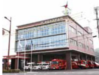
3月に完成した消防新庁舎
