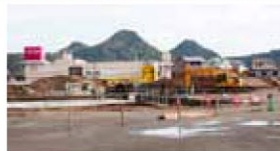
建設中のイオンタウン
