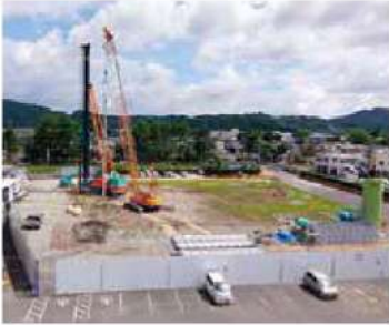
加治木庁舎横グラウンドに建設中の加治木複合新庁舎。2023.6.28撮影
