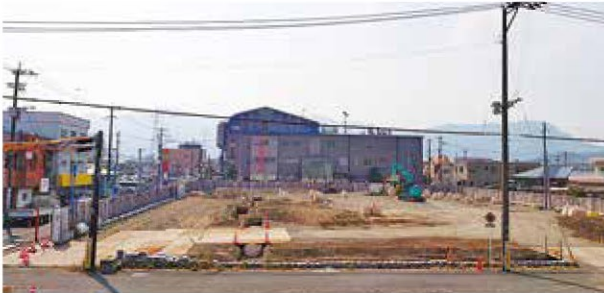
基礎工事の準備をすすめている始良庁舎本館建設敷地。画像中央奥は2号館。現場事務所から撮影。R4.2.22時点
