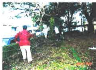
垂れ下がる枯れ枝などを撤去
