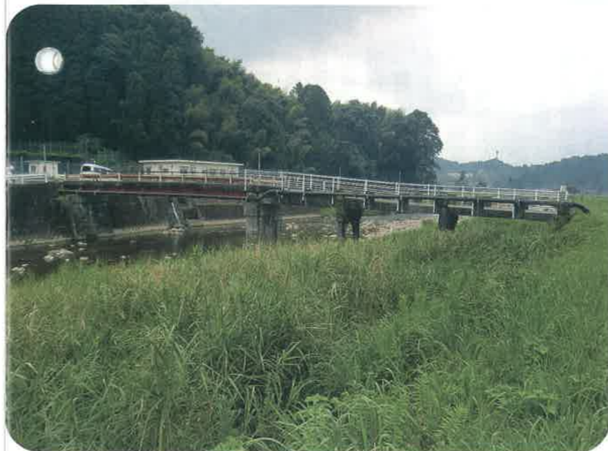
▲蒲生地区の水道管が併設されている山元橋
