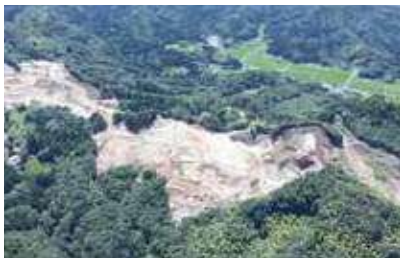
山田地区で行われているメガソーラー開発工事
