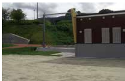
人工芝グラウンドから、多目的広場へ向かう階段の設置
