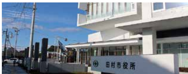
▲免震構造で建設された田村市役所
