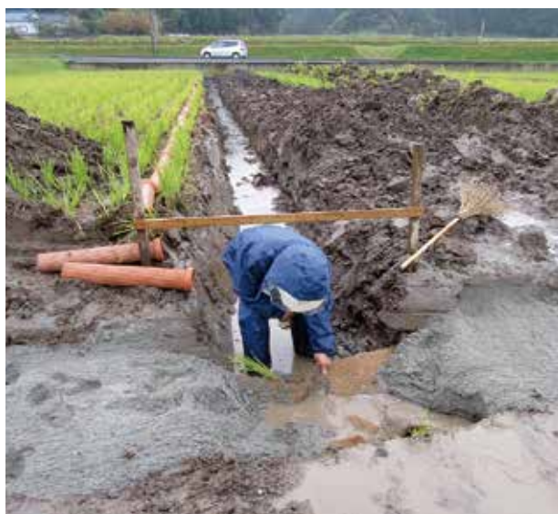
▲素焼き土管に変更されて施工される暗渠排水事業 (蒲生町下久徳地区)
