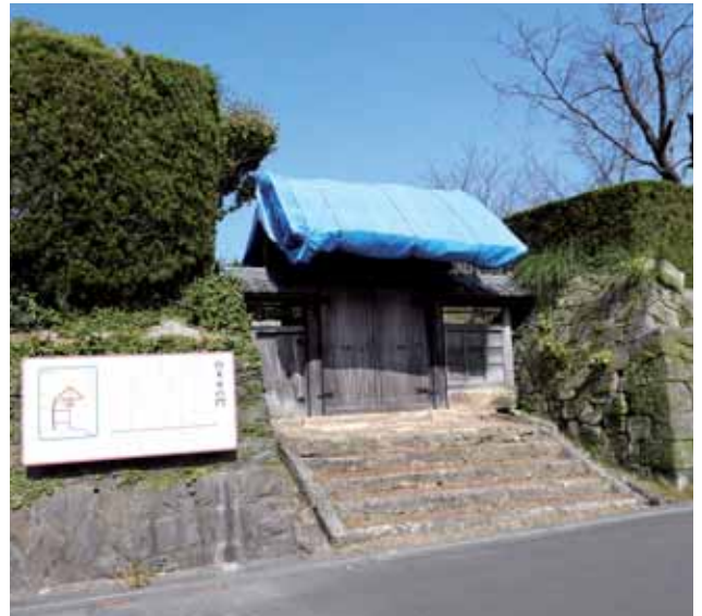
▲早期改修が望まれる曾木家の門
