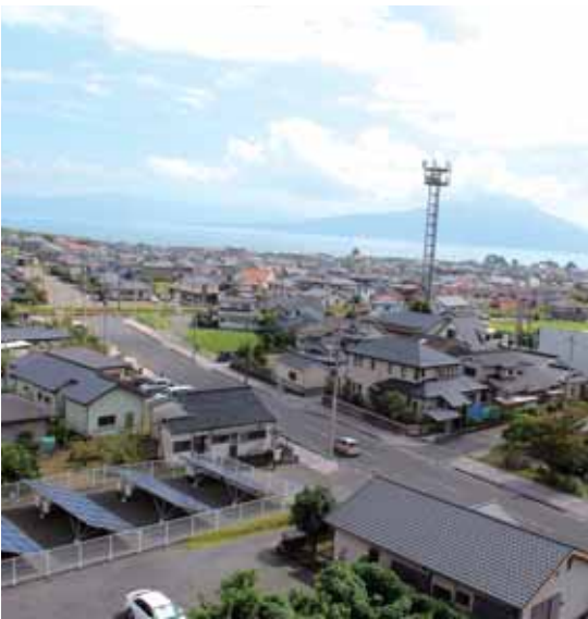
▲30年度完成を見込む都市計画道路森山線と松原線
