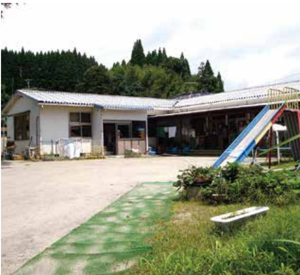
▲浸水被害もある小山田保育所
