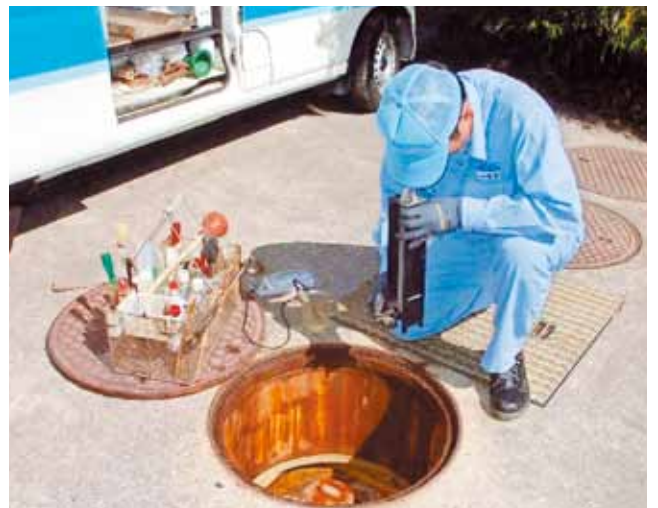
▲月1回の保守点検実施中
