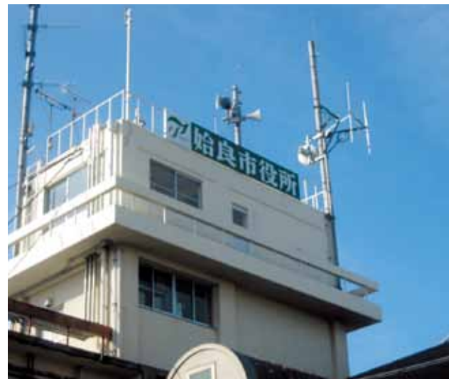
▲本庁舎屋上にあるデジタル防災行政無線アンテナ
