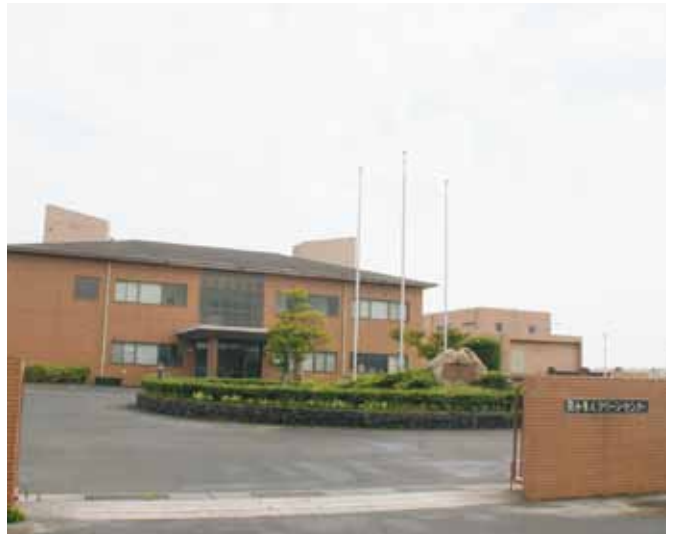
▲霧島市の国分隼人クリーンセンター
