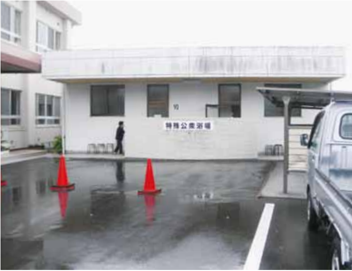
▲トイレもなく別棟まで走り込む状態の浴場(三叉コミュニティセンター)
