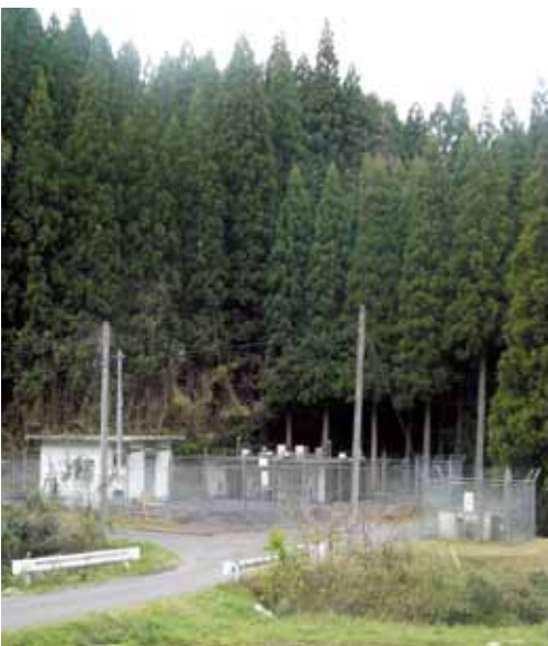
▲漆地区民の大切な水源池
