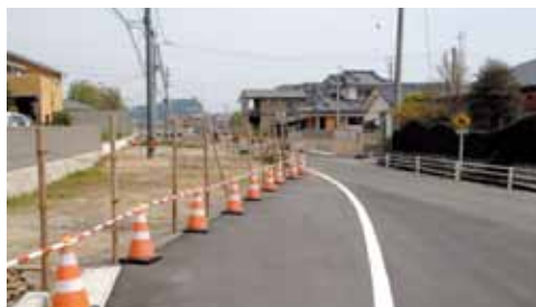
▲いよいよ工事が完了します
