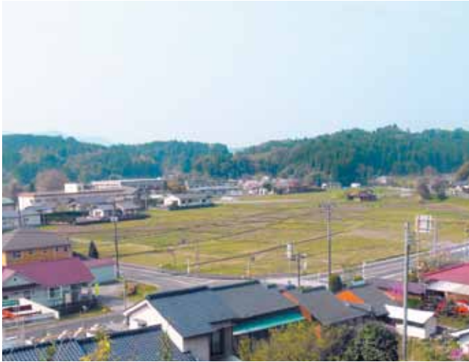
▲山田地区の市営住宅建設予定地
