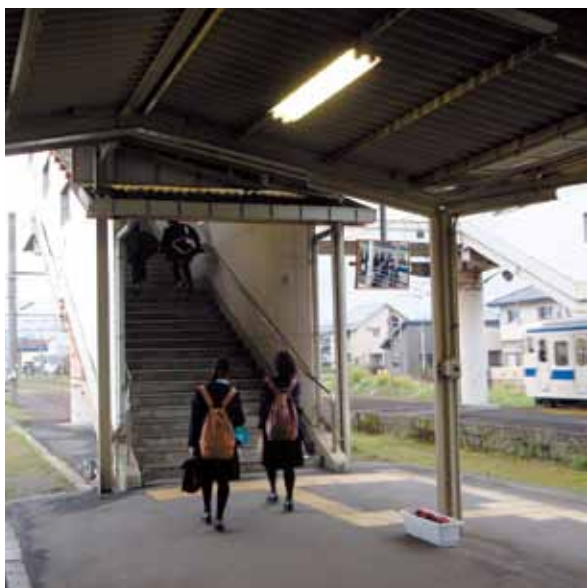
▲エレベーター設置が望まれる加治木駅
