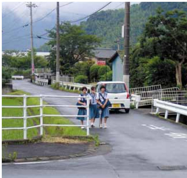
▲今年整備予定の高樋～南宮島線
