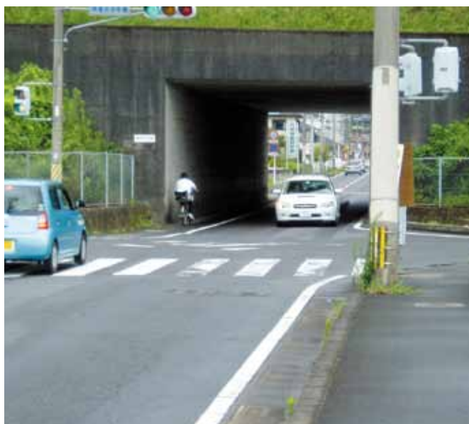
▲改善を望む高速道下トンネル
