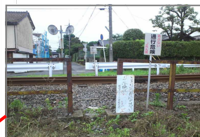
遮断機のない場所
